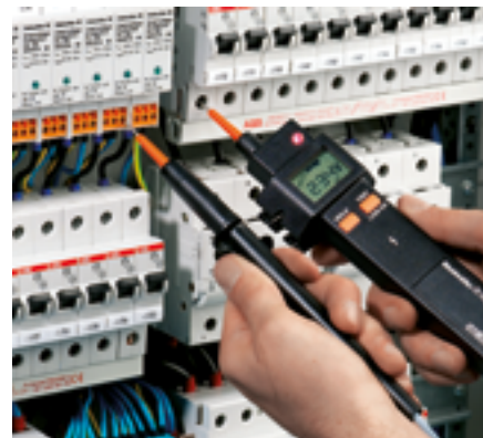
Hibakeresés kétpólusú feszültségteszterrel (vizsgálóhüvellyel IEC 61243-3 szerint)
