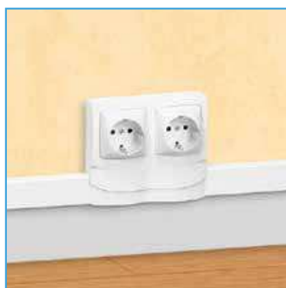
Oteo szerelvények csatornához rögzítése
