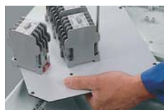
Készülék beszerelése szerelőlapokra
