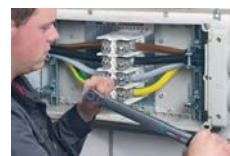
A kapcsokat a megadott nyomatokkal kell meghúzni
