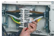
Kaparással a vezeték végéről gondosan el kell távolítani az oxidréteget.
