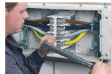
A kapcsokat a megadott nyomattékkal kell meghúzni
