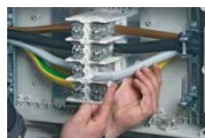
Dörzsölje be a vezetékvéget sav- és alkálimentes zsírral, majd rögtön csatlakoztassa.
