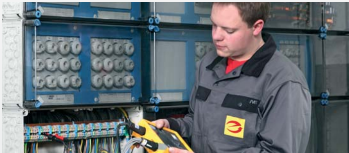
Energialeosztók 630 A-ig energia-elosztóberendezés-kombinációként (PSC) az MSZ EN 61439 2. szerint
