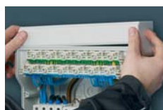
Esztétikus szerelés a tartozék kábelbevezető burkolatnak köszönhetően
