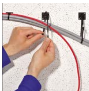
1. Helyezze a kábelkötegelő vékony részét a nyitott zárófejbe.
